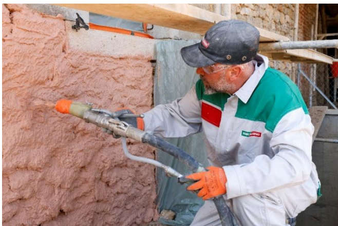
Chantier à Valay (70140), d'un ancien corps de ferme en pierre de 490m 2 , avec utilisation du sous-enduit PAR HÉRITAGE SE et l'enduit de finition CALCIDÉCO.
